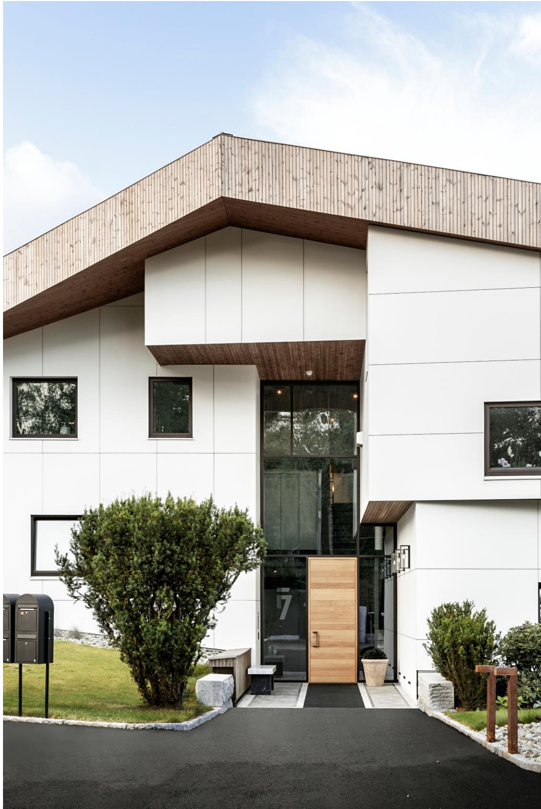
Abb. 2: Fassade mit Largo Faserzementplatten und unsichtbarer Befestigung
