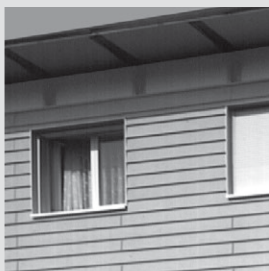
Plaques de façade superposées au chevauchement et fixées invisiblement.
