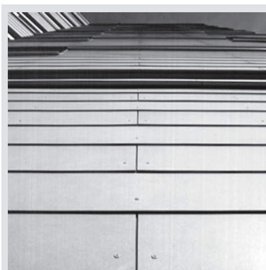
Fixation discrète des plaques de façade posées à clin par rivets colorés.
